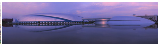
上海光源工程
